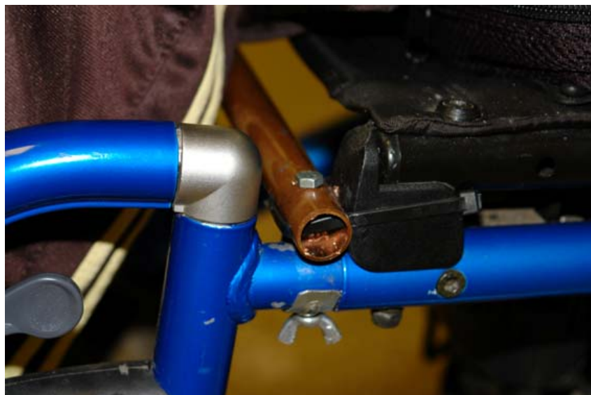
Fijación del soporte a la silla de ruedas.
