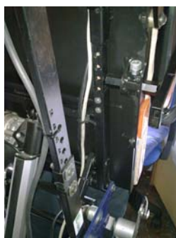
Fijación de los cables con las bridas.
