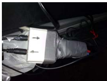
Caja de conexiones para pulsadores.
