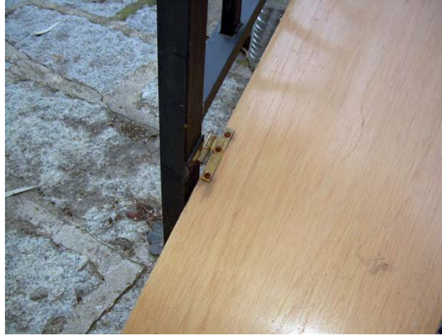
Los pernios que permiten desmontar la rampa de la escalera.
