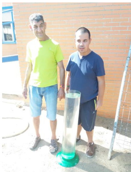
Comprobando la estanqueidad.
