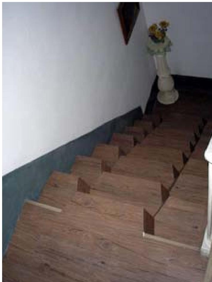
Imagen del módulo escalón-rampa colocado en una escalera. Vista desde arriba.
