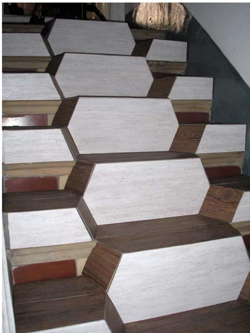
Imagen del módulo escalón-rampa colocado en una escalera.
