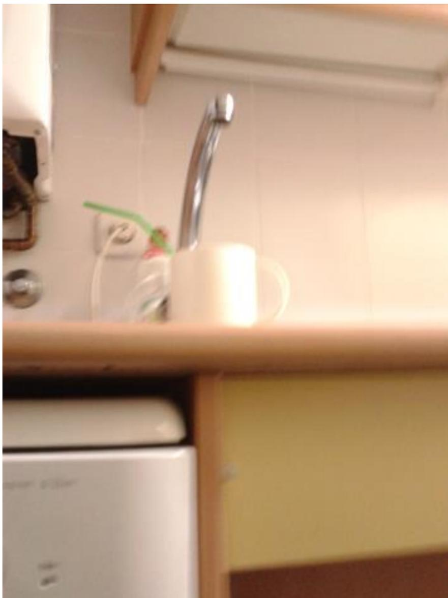
Imagen del grifo colocado en la parte lateral de la pila o fregadero lo que permite un mejor alcance y trabajo con él.
