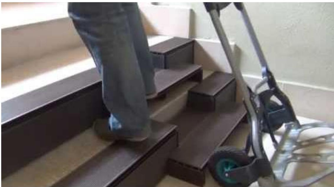
Imagen de la adaptación instalada en la que se muestra el uso con una carretilla de carga.
