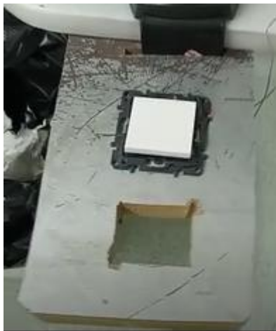
Imagen 5: Se hace soporte de madera para el cepillo y para el interruptor.
