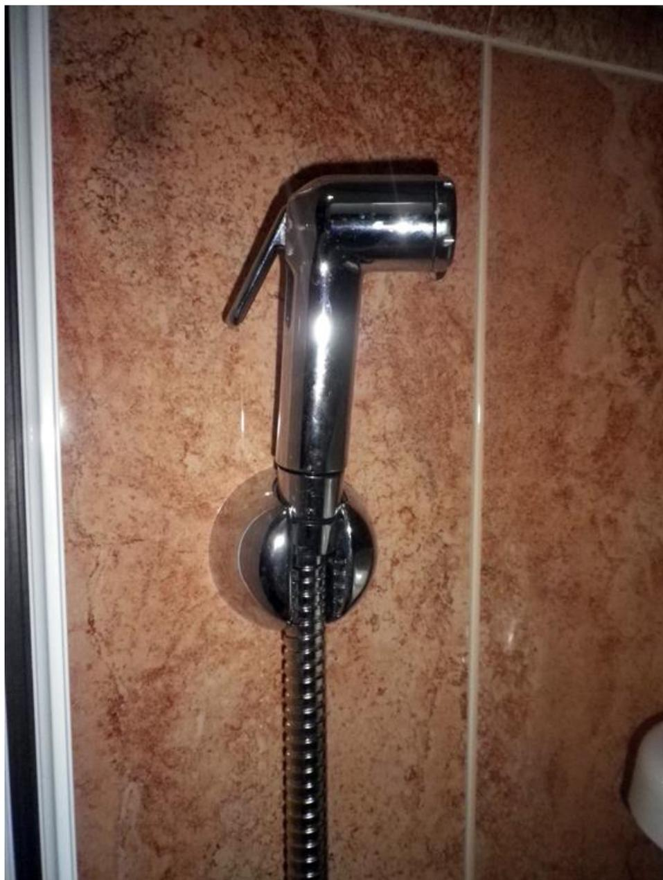
Imagen del terminal de ducha colocado en el lateral del inodoro. Se puede apreciar la pestaña que abre y cierra el paso del agua.
